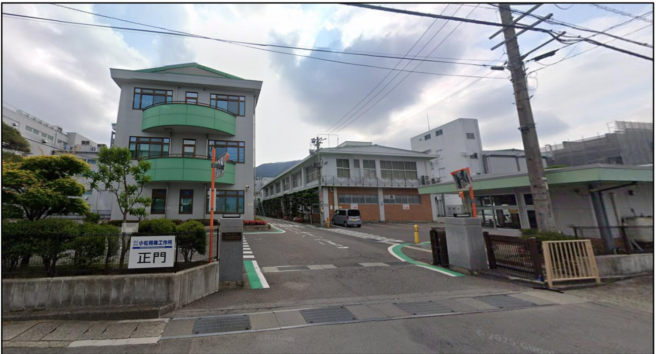
▲(株)小松精機工作所 本社工場 正門
